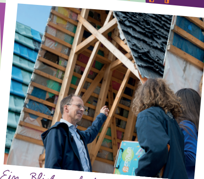
Ein Blick auf die Dächer von Sammlers Traum.
